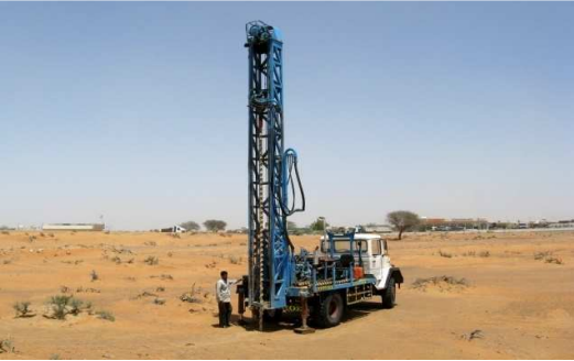
الشكل 17: الحفر حتى عمق 10 متر باستخدام الحفار الدوار.
